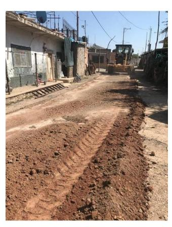
vibrocompactador y retro excavadora, con un avance rehabilitado de **20 kilómetros de longitud por 6 metros de ancho.**
